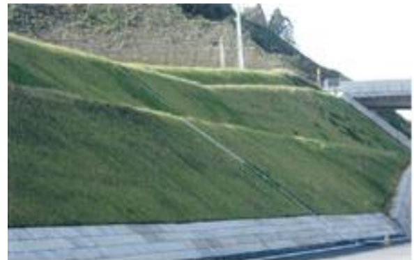
バイオプラスターチ吹付工 pH3.6の強酸性土壌法面育成状況 (施工後5ヶ月経過)
