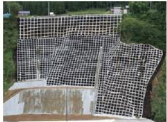
グラウンドアンカー併用現場吹付法枠工
