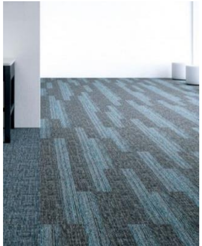
カーペット工事
