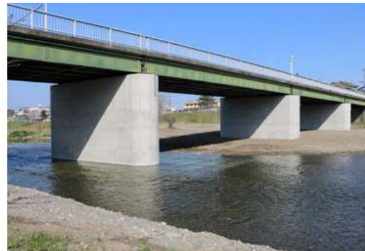
埼玉県入間市 橋脚耐震補強工事
