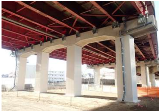
埼玉県入間市 橋脚補強工事
