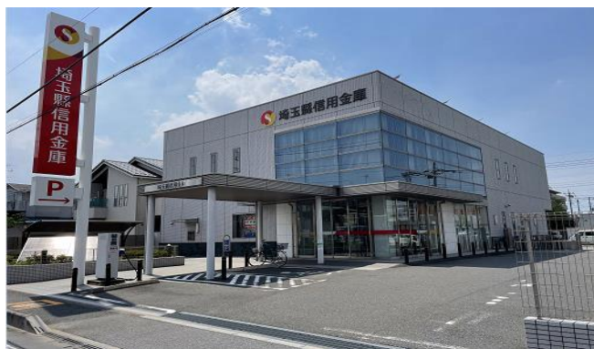
川口朝日支店 外観
